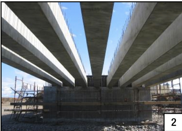
Figur 1. Platsbyggda stöden, Figur 2. Långsgående prefabricerade balkar på stöden, Figur 3. Montering av formplattor, Figur 4. Färdig bro över Skenaån (Skänninge).
